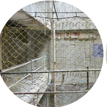
高處開口設置防墜網
