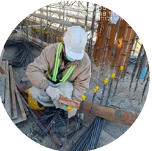
裸露鋼筋加裝防護套
