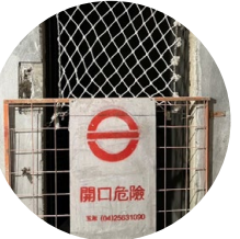
電梯開口處設置欄欄、防墜網及警示標語
