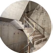
樓梯設置扶手護欄
