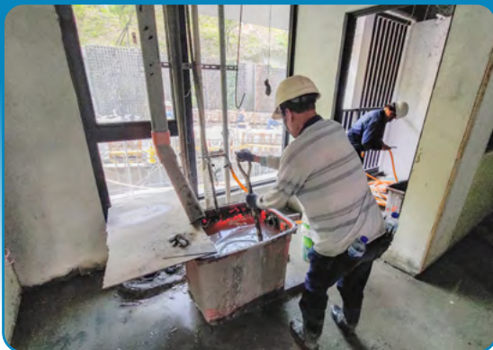
工地設有沉沙桶，廢水經初步沉澱後，再進行排放
