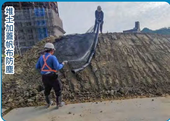
裝設防塵網並設置有效澆水系統
