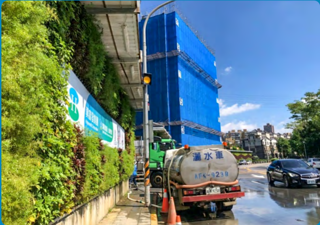
裝設防塵網並設置有效澆水系統
