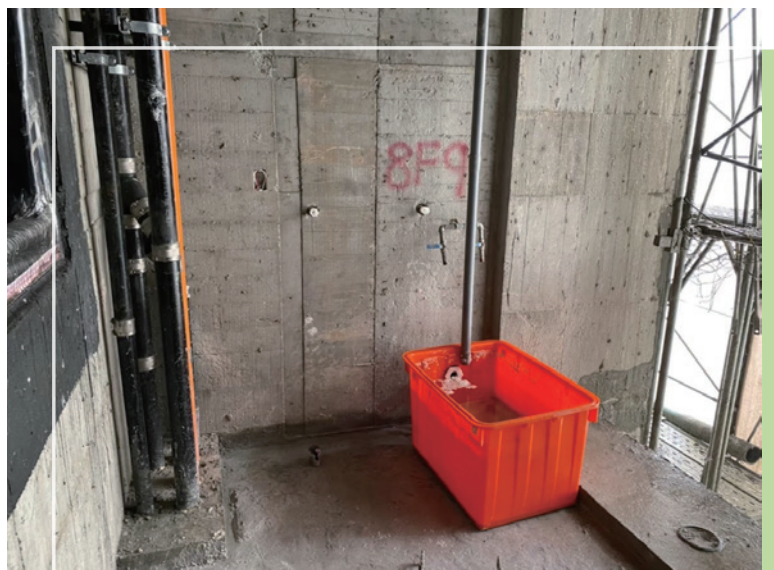
工地設有沉沙桶，廢水經初步沉澱後，再進行排放
