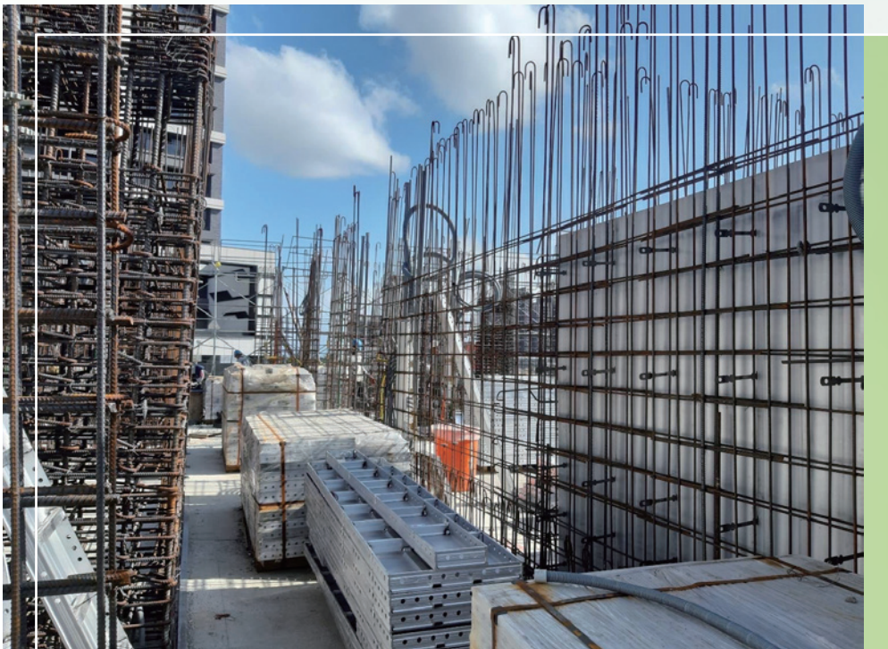
用鋁模板取代傳統木模板
